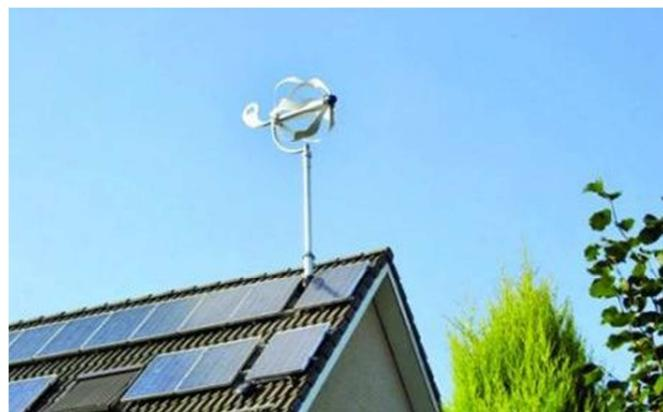
Fig.1 Turbina Venturi amplasata pe acoperisul unei case [1]
